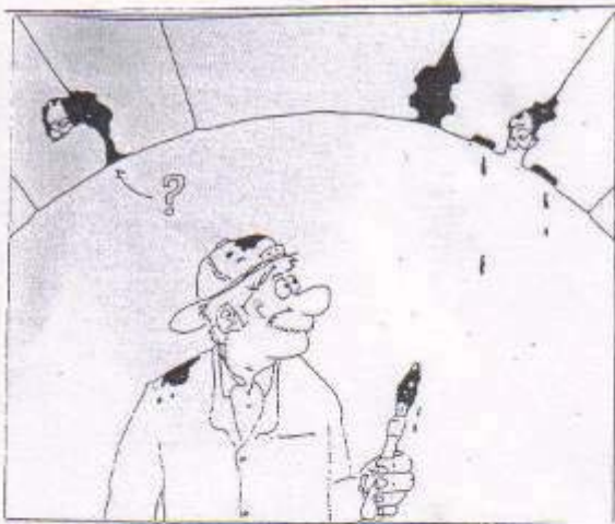
3. Les disjointements qui seront conservés pour les chauves-souris sont choisis, puis entourés d'un trait de peinture de couleur pour éviter leur obturation lors des travaux.
