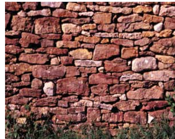
Mur fait de moellons de minerai de fer
