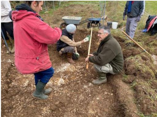
*Avec un morceau de bois et un téléphone portable (application niveau à eau), nous avons contrôlé la profondeur et le nivellement de la mare. Nous avons placé un point bas pour l'évacuation du surplus d'eau ; ainsi que des gradins pour faciliter une colonisation par des espèces différentes.*
