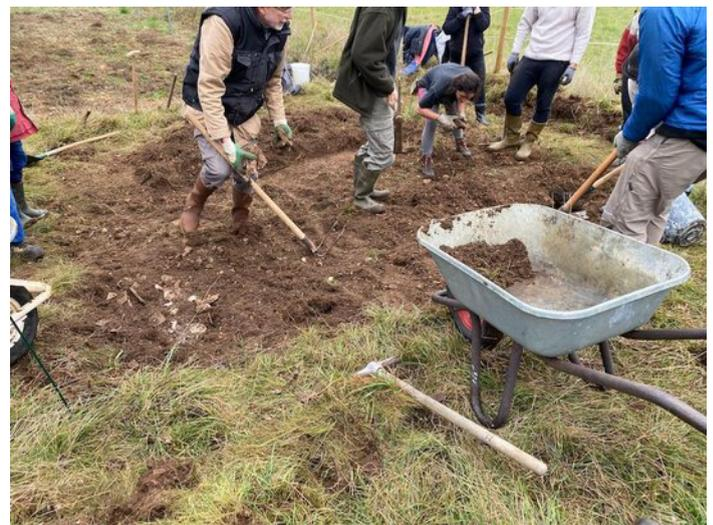
Nous avons mis des piquets pour délimiter la zone en mesurant 4m sur 3m. La mare doit avoir une zone qui fait jusqu'à 80 cm de profondeur pour permettre à certaines espèces de s'y réfugier en cas de manque d'eau, ou, en hiver en cas de gel. Elle doit aussi avoir une pente douce pour permettre aux animaux d'y accéder.
