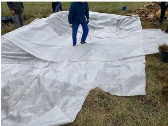
*Le géotextile permet d'éviter que des plantes ne poussent et percent la bâche ; il protège aussi des pierres. Nous en avons placé deux couches avant d'installer la bâche ; celle-ci est biodégradable ; elle tient 20 ans et n'a pas d'impact sur l'environnement.*
