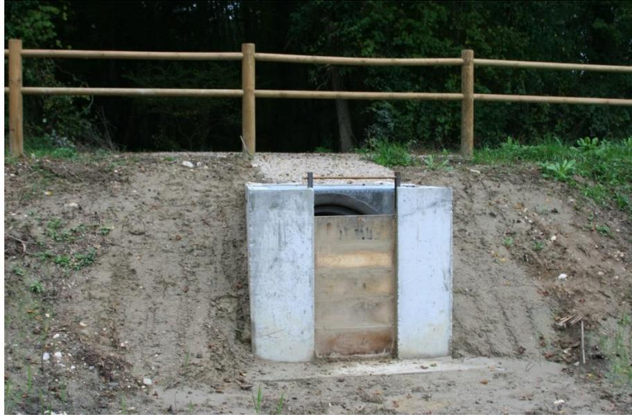
Figure 5 : Ouvrage de régulation des eaux de l'étang Barral (vue de face) lors de sa pose en 2013
