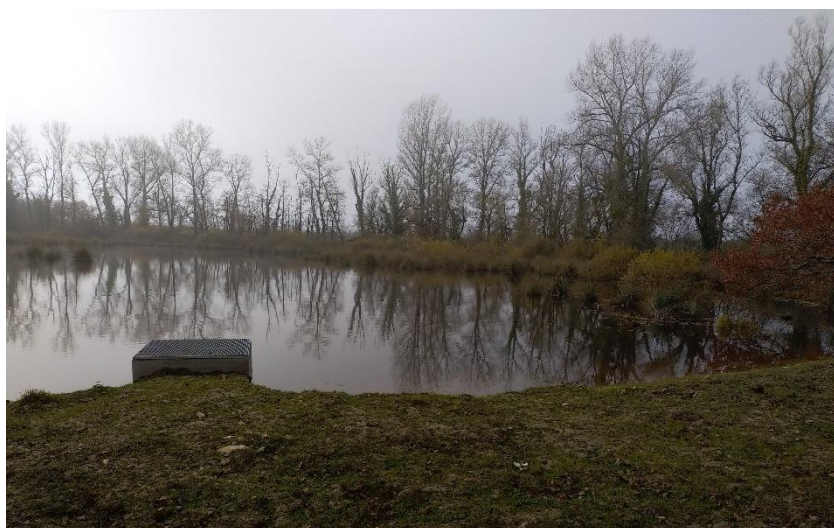
Restauration de l'ouvrage de gestion des eaux du marais du Marterin, Réserve Naturelle Régionale des étangs de Mépieu. Raphaël Quesada
